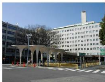
日本大学医学部附属板桥医院
